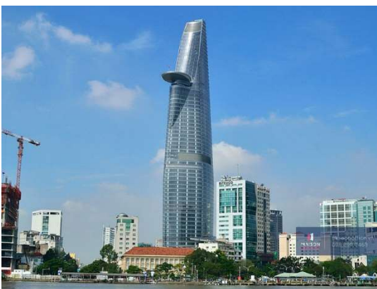
Bitexco Financial Tower Quận 1- Tp HCM
